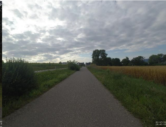
Abbildung 4-11: Radweg an der Radolfzeller Str.
