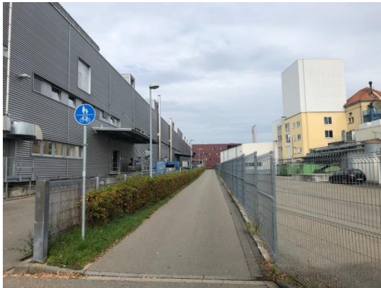
Abbildung 4-24: Radolfzell, Führung im Bereich des „seemax-Outlet“
