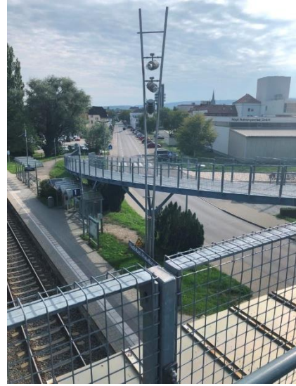
Abbildung 4-23: Radolfzell, Überführung der Bahn, „Haselbrunnsteg“
